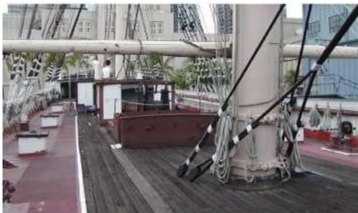
Vista de una cubierta principal, mixta (madera-metal)
